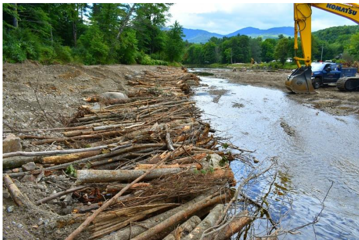
Figura 3: Estructura de Toe-Wood para la recuperación de la planicie de inundación. Imagen tomada de la página de la asociación “Ausable River Association”:
